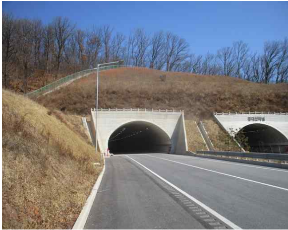
1공구 봉대산터널(서울) 시점부
