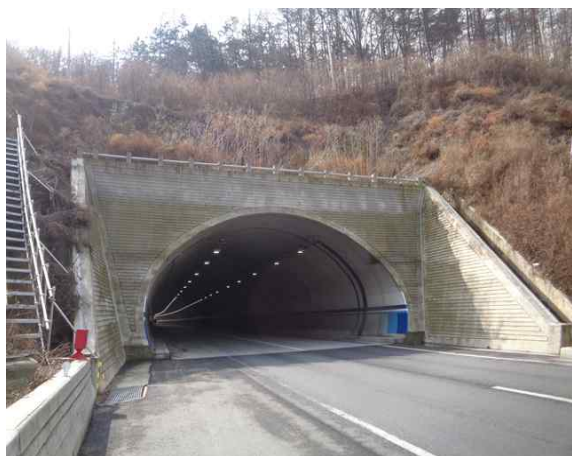
4공구 금촌터널(문산) 종점부
