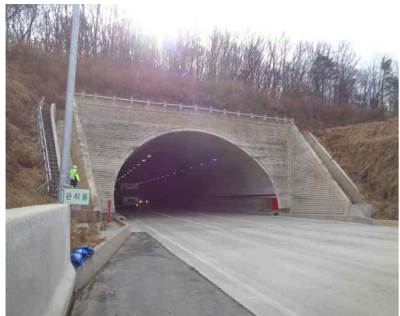
3공구 견달산터널(문산) 종점부
