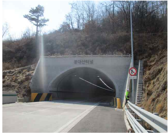
1공구 봉대산터널(서울) 종점부
