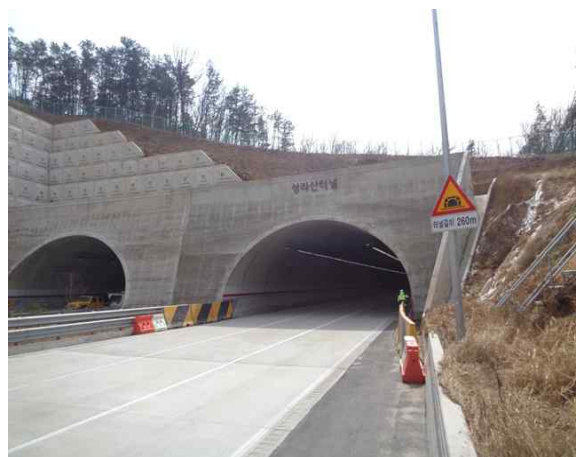
1공구 성라산터널(서울) 종점부
