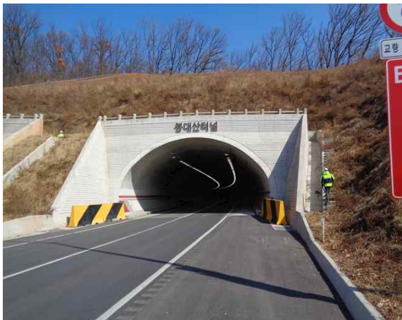
1공구 봉대산터널(문산) 시점부
