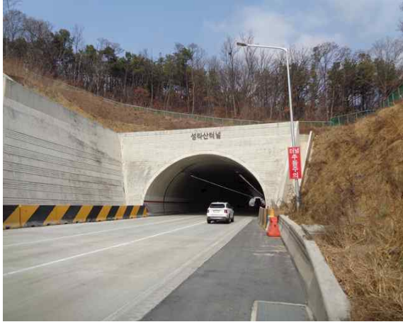
1공구 성라산터널(문산) 시점부
