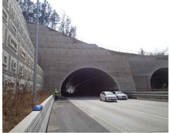
1공구 성라산터널(문산) 종점부
