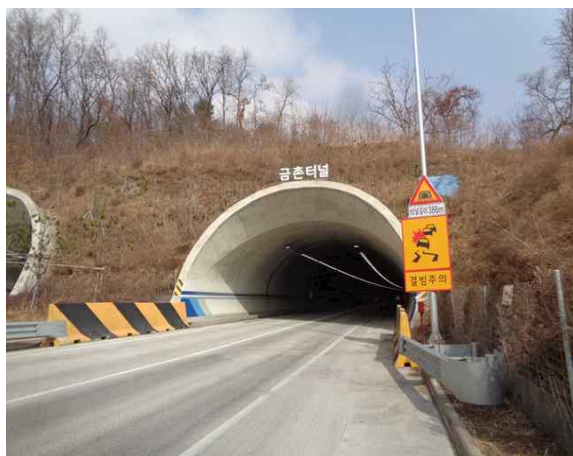
4공구 금촌터널(문산) 시점부
