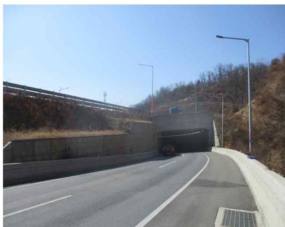
1공구 봉대산 지하차도 종점부
