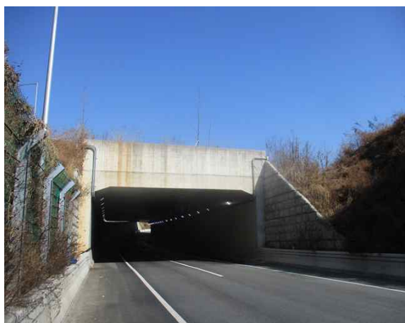
1공구 봉대산 지하차도 시점부
