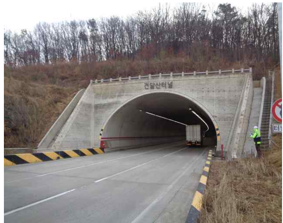
3공구 견달산터널(서울) 종점부
